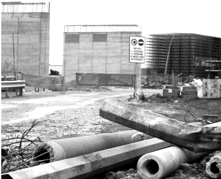
Lavori di costruzione dell'Alta Velocità presso la piattaforma distributiva della Number One a Parma
